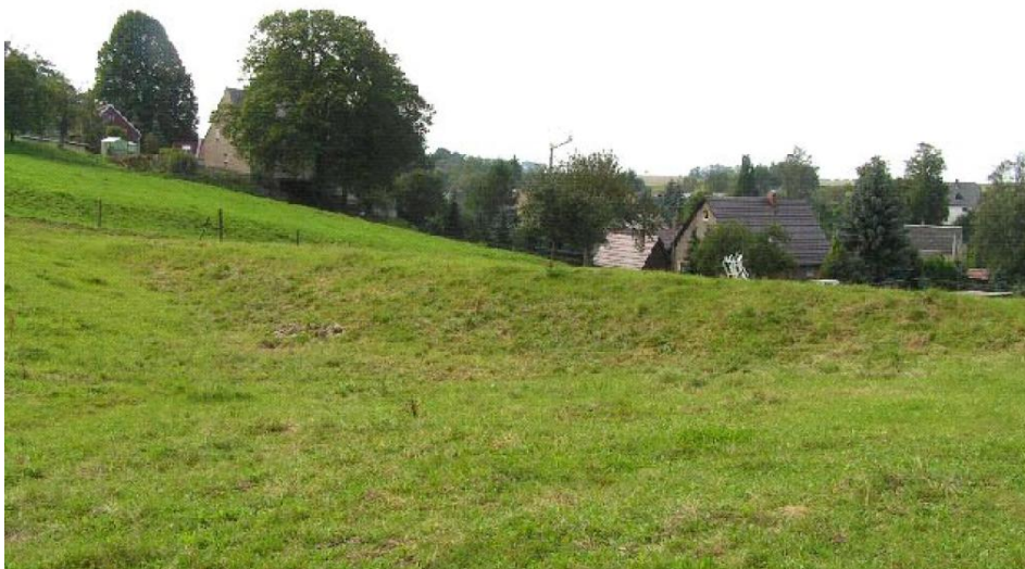
Abbildung 23: Beispiel eines Rückhaltedammes für die Speicherung von Oberflächenabfluss in Mulden und zur Förderung der Infiltration. Quelle: Freistaat Sachsen (2002).
