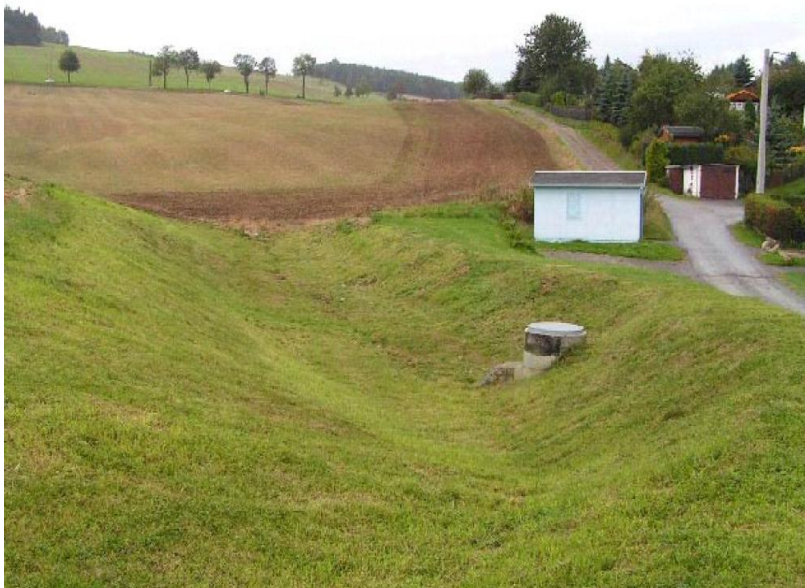
Abbildung 24: Auffangbecken für den Oberflächenabfluss. Quelle: Freistaat Sachsen (2002).
